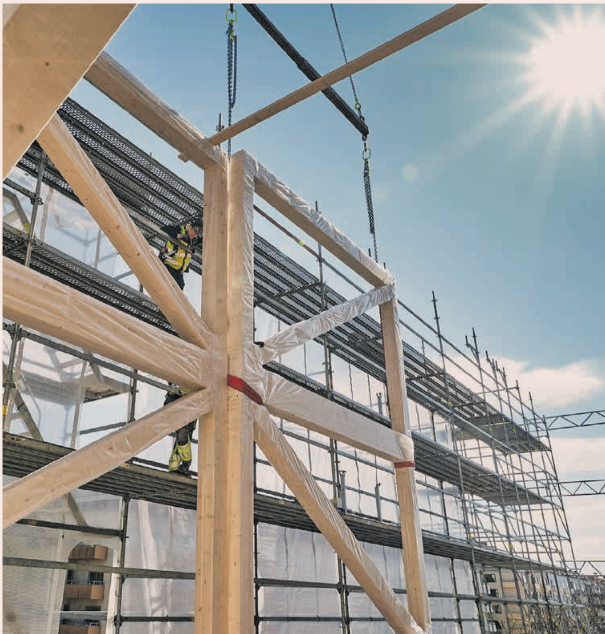
Gibraltar Guest House byggs just nu utanför Chalmers tekniska högskola i Göteborg. Det blir 100 studentbostäder i sex våningar. Arkitekturen är unik genom att en hybrid av flera olika träbyggnadstekniker används. Foto: Bruksbild.se
